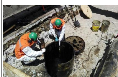
Fotografía 4 Demolición, limpieza y tapado de cámara existente, en tramo inicial
