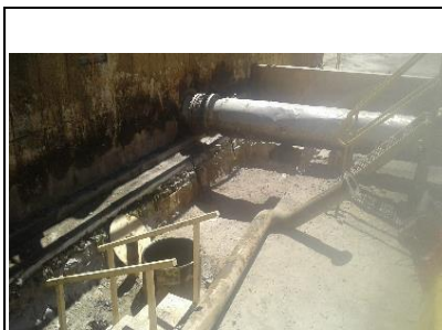
Fotografía 2 Retiro de interferencia de cámara existente
