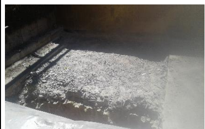
Fotografía 3 Instalación de carpeta de HDPE en zapata inicial
