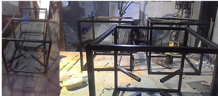
Figura 6.5. Armado de estructura modular para montaje de estanques.
