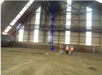
Lugar donde cayó trabajador y Grating que se utilizaba como plataforma de apoyo del trabajador.
