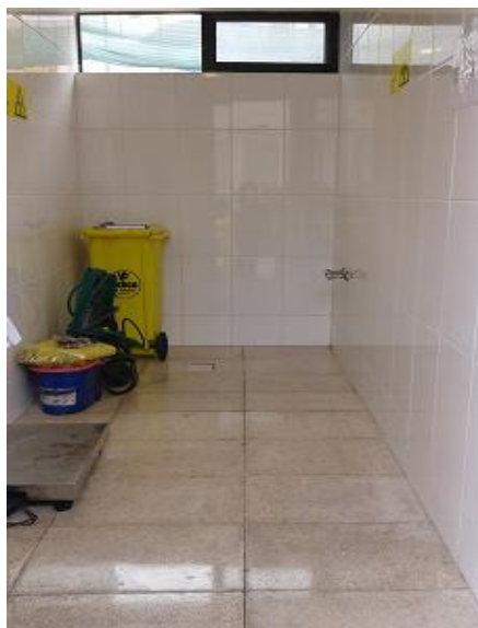
Fig.22: Salas de Almacenamiento de Residuos con programa de limpieza diaria y desinfección semanal (Fuente: CAN de Antofagasta).
