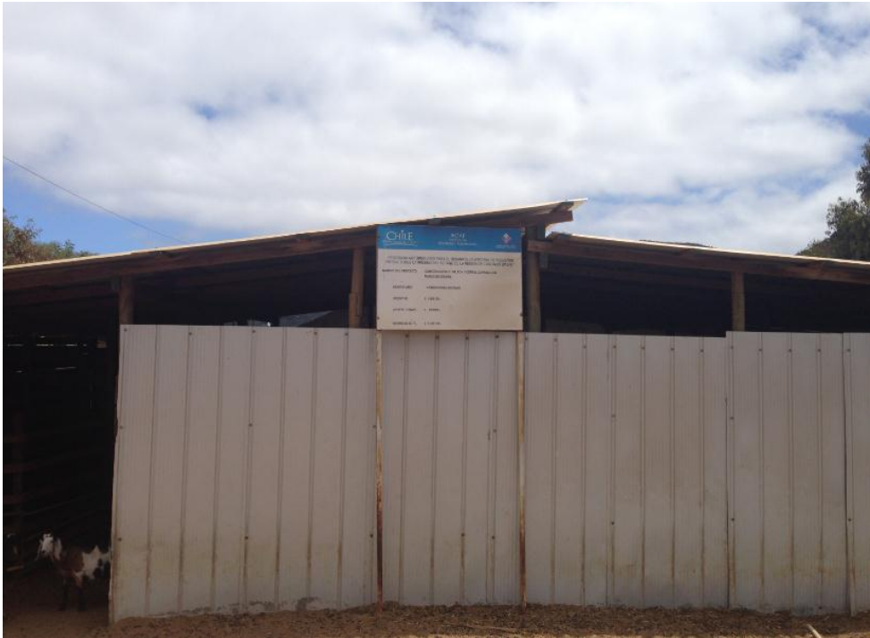
Figura N° 10: Fotografía de galpones techados con estructura de madera y cubierta de aluminio.
