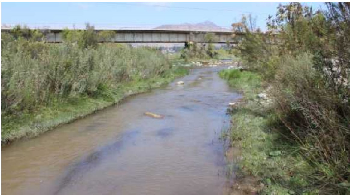
Figura N° 14a: Estación EL-16, Río Elqui, Vista Oriente.
