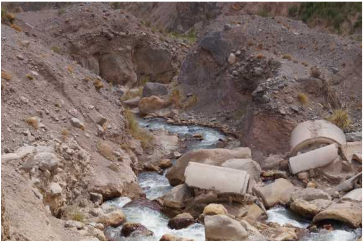
Figura N° 17b: Estación RT-1, Río Toro, Vista Poniente
