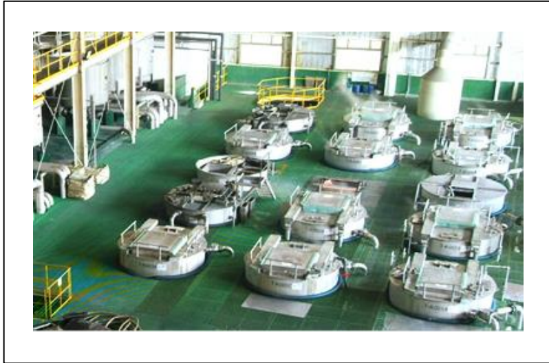
Figura 17 Estanques disolvedores –acondicionadores
