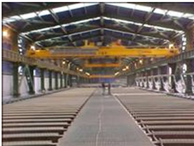
Figura 11: Nave de EW – Minera El Tesoro.
