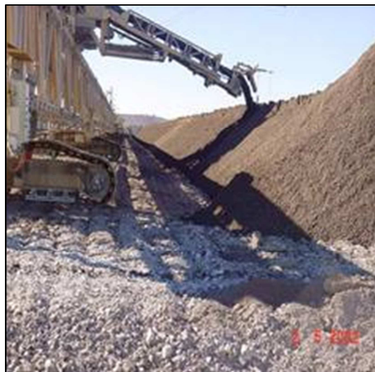
Figura 8: Puente apilador - Minera El Tesoro.
