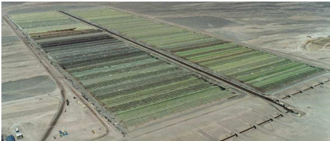
Figura 9: Pila dinámica de Lixiviación – Minera El Tesoro.
