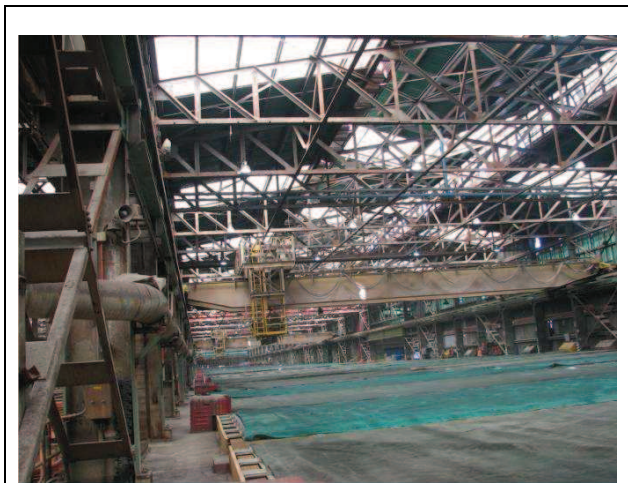
Figura 4: Vista longitudinal de la nave Electro Refinación.
